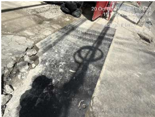
รูปที่ 18 แผ่นเหล็กอย่างหนาปูพื้นที่เดินรถในโครงการ
