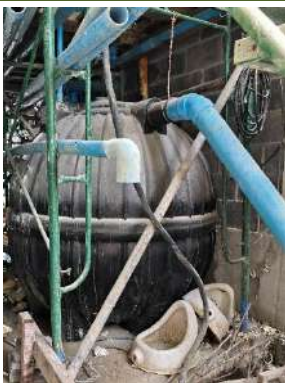
รูปที่ 22 ถังบำบัดน้ำเสียสำเร็จรูป
